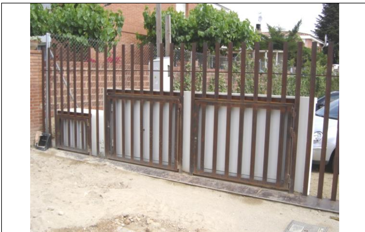
Doble porta dels armaris d'instal·lacions integrada en la tanca.
