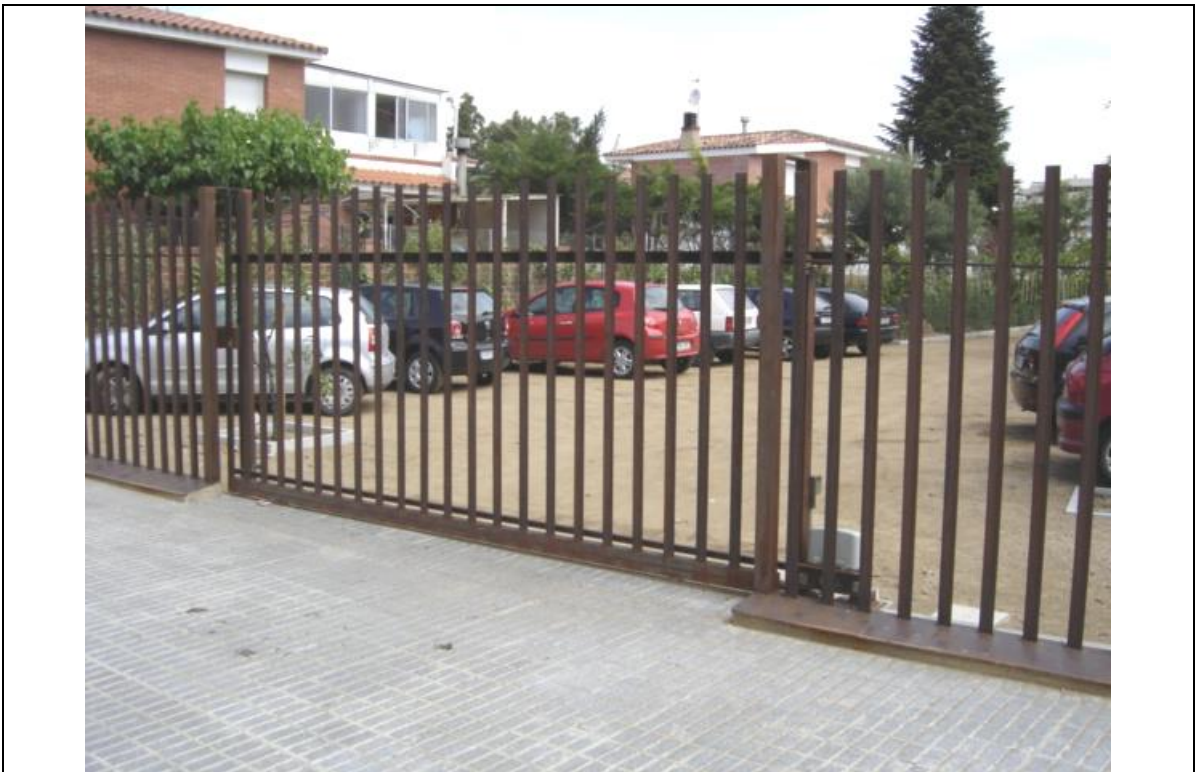
Porta corredissa motoritzada, amb doble arc de suport.
