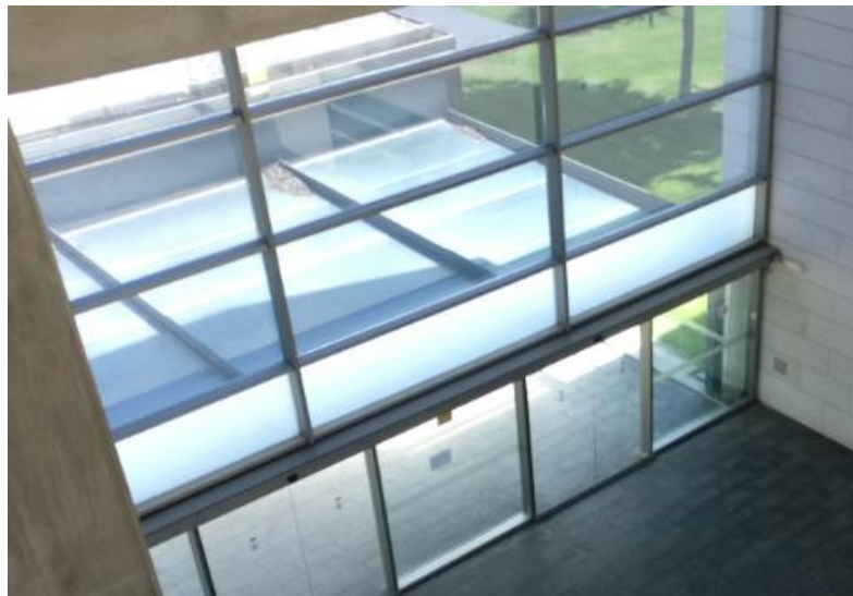
Tancaments de vidres a la entrada principal
