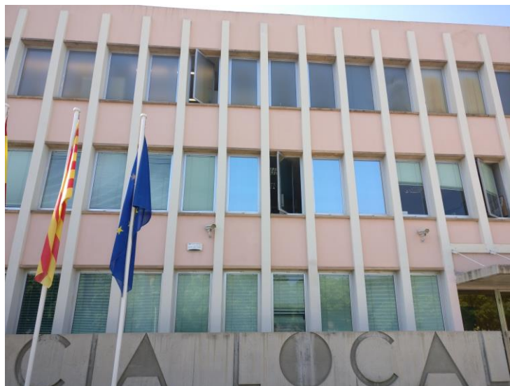
Sud-est (Façana principal)
