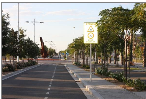
Foto 3. Senyalització de la Zona 30 en l'àmbit dels vials que formen part del sector i que permeten la convivència de bicicletes i vehicles en calçada, sense necessitat de segregat
