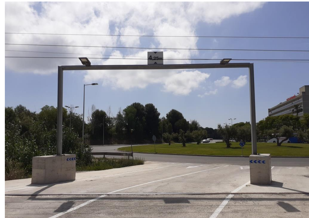
PÒRTIC DE SENYALITZACIÓ VIÀRIA DE L'ACCÉS PROVISIONAL ACTUAL ENTRE LA ROTONDA DE L'AVINGUDA JOAN FUSTER I L'AVINGUDA EDUARD PUNSET
