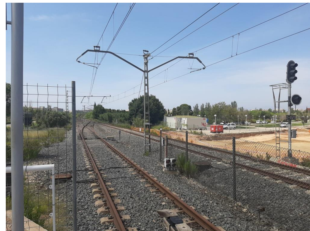
Traçat ferroviari actual a desmuntar per ADIF i obres d'execució de la nova estació de Salou – Port Aventura
