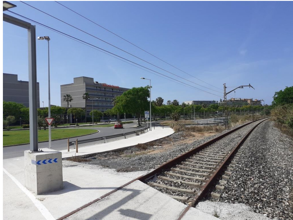
Traçat ferroviari actual a desmuntar per ADIF que creua l'accés provisional entre l'Avinguda Joan Fuster i l'Avinguda Eduard Punset
