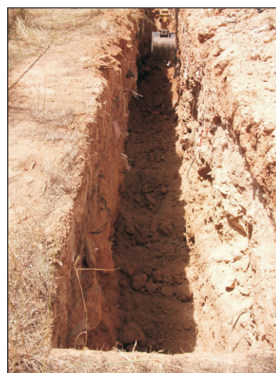
Foto 10. Vista est - oest de la rasa 600.
