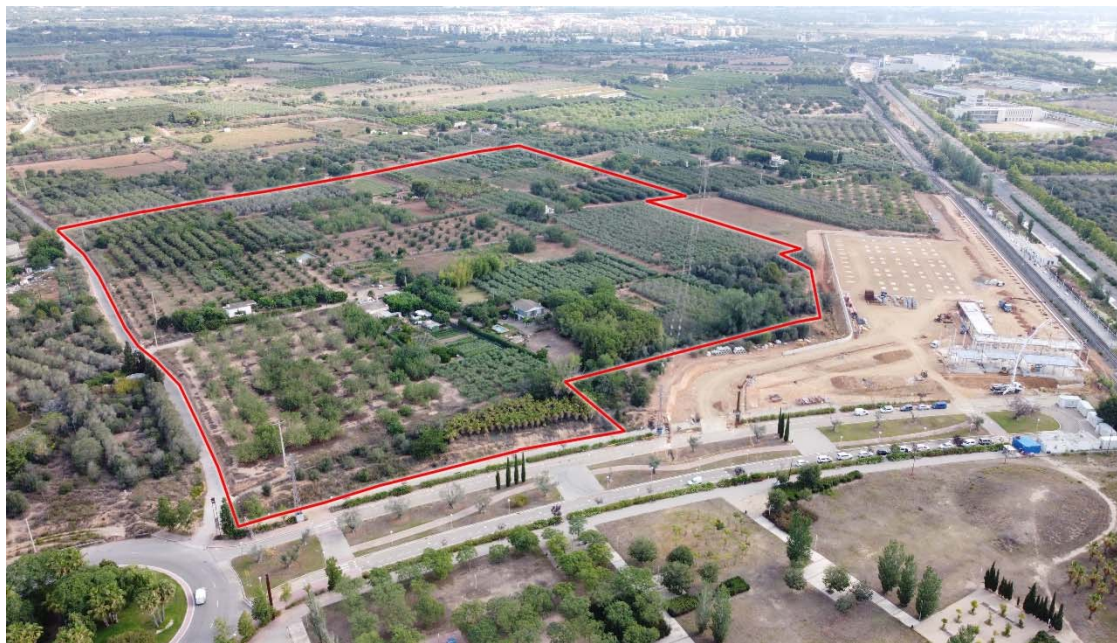
Vista Aeria de l'àmbit de la Modificació de POUM
