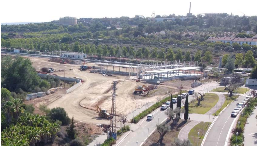
Estat actual i obres de construcció de l'estació de ferrocarril
