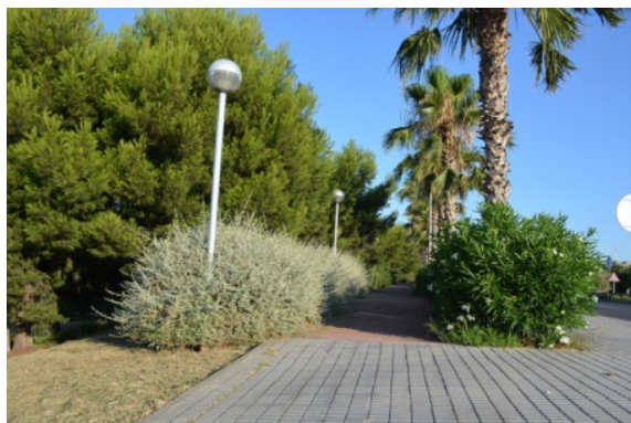
Figura 126. Carril Bicicleta segregat a l'autovia de Reus – Salou.
