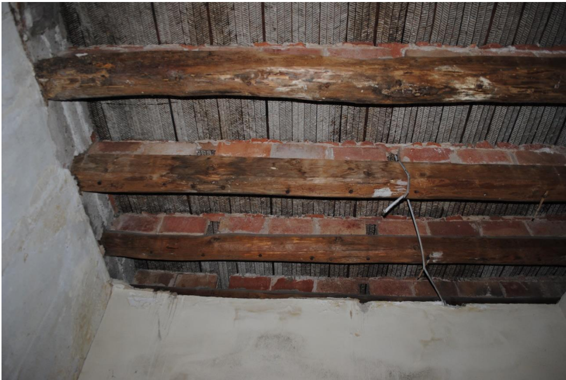
Forjat de coberta de planta primera amb biguetes de fusta, maons de recolzament i malla metàl·lica com encofrat d'entrevigat.
